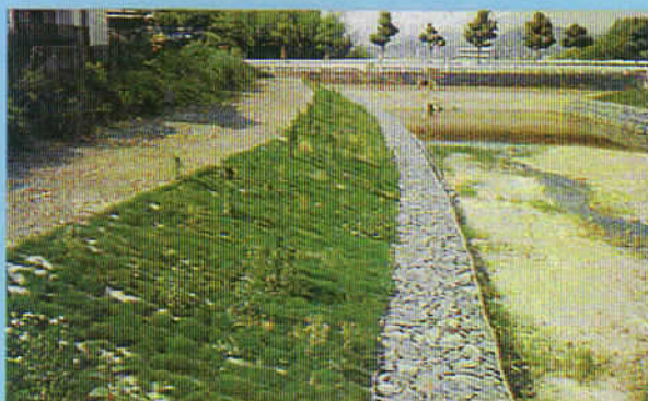
池の堆積土改良工—法面改修利用
