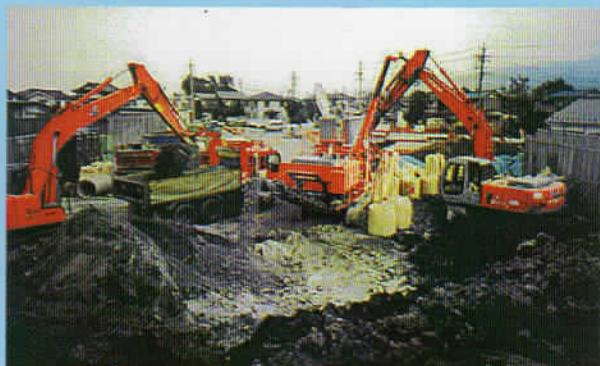
下水管布設シールド工—改良土搬出路床利用 (CBR20%)
