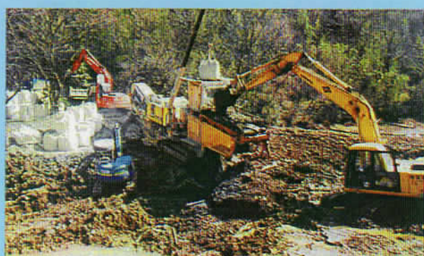
池の堆積土改良工—改良土搬出造成利用
